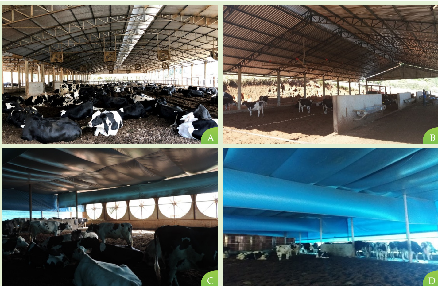
Figura 6. Detalhes da instalação Compost Barn . (A e B) Com as laterais abertas e (C e D) fechadas.
